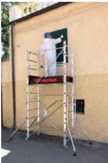
**Trabattello Pontal 2000.** Trabattello componibile interamente in alluminio, estremamente veloce da montare; ogni fiancata ha un peso di soli 6 kg, ripiani realizzati con strutture in alluminio e superficie in legno, ruote di tipo piroettante con freno; portata: 150 kg; altezza massima raggiungibile: 4,5 m; misura di base 60x140
